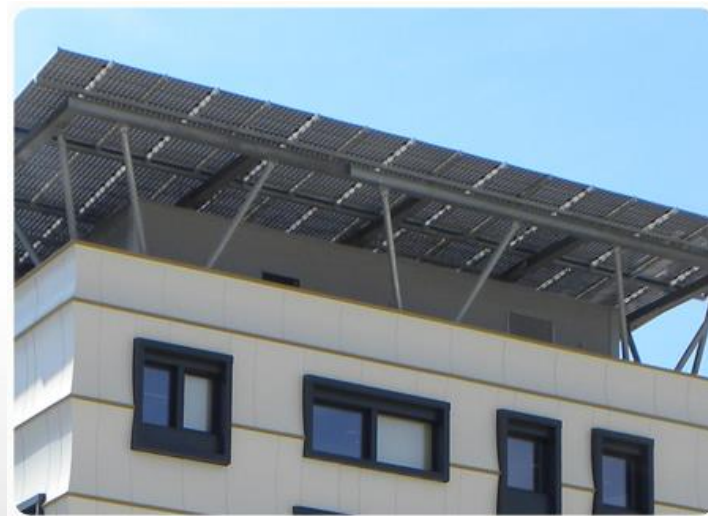
Panneaux photovoltaïques (Caserne de Bonne – Grenoble - 38)
