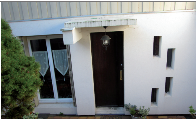
Des espaces extérieurs diversifiés sur des lots de taille réduite (loggia, terrasses, jardin...). Ici, vue sur le perron.
