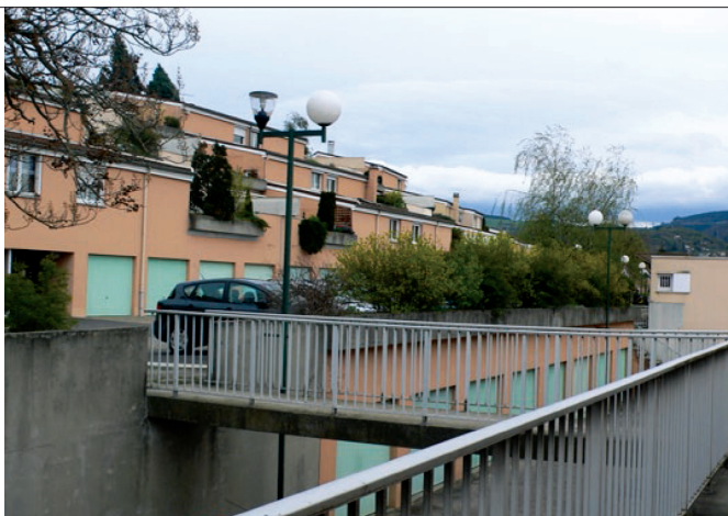
Des garages aménagés au rez-de chaussée des logements d'où la présence de passerelles à certains endroits.
