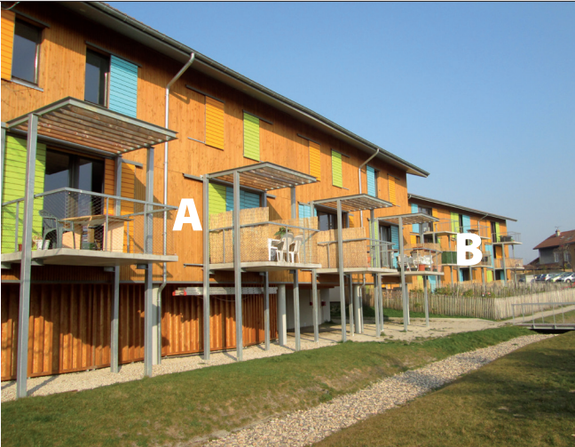
Vue sur le collectif côté jardin (n°A).
