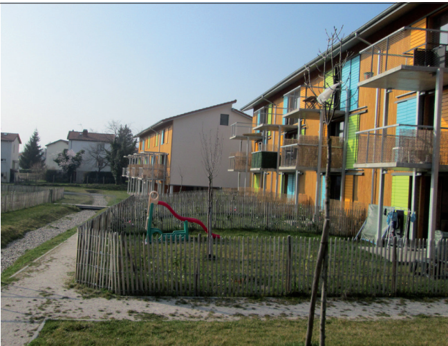
Vue sur le collectif côté jardin (n°B).
