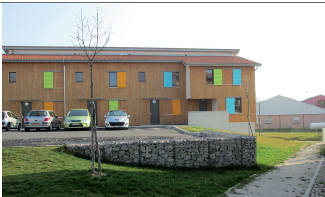
Des espaces extérieurs traités avec soin (murs de soutènement, pelouses et gravier perméables aux eaux de pluie).
