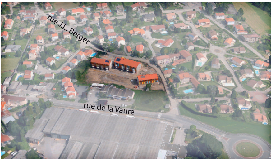
Eco quartier de l'Aubier dans son environnement proche
