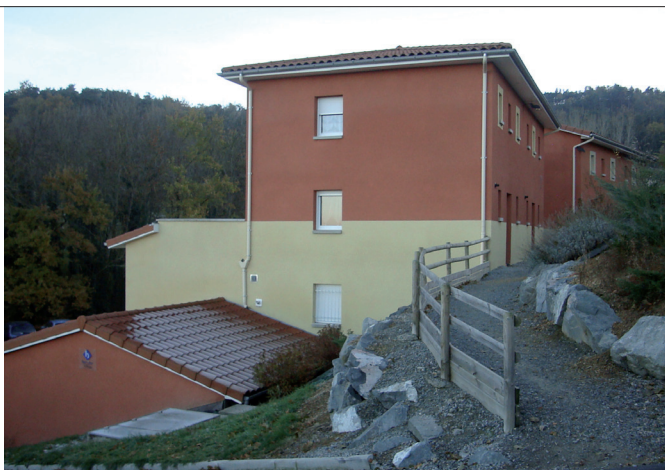
Allée piétonne pour accéder aux logements à mi-pente.
