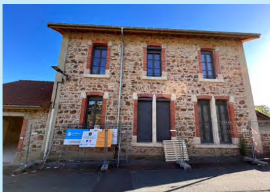
Ancienne école et mairie, après travaux, vue de la rue et vue arrière (jardin partagé) ©Juré
