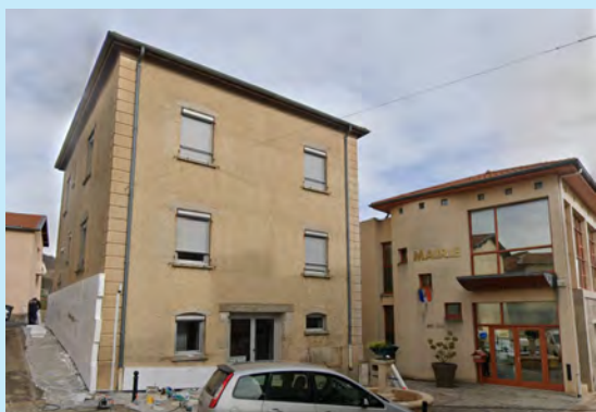
Maison Relave © Google (en cours de travaux en février 2021)
