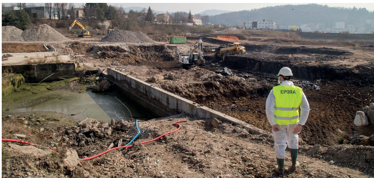
Chantier de dépollution du projet Steel
