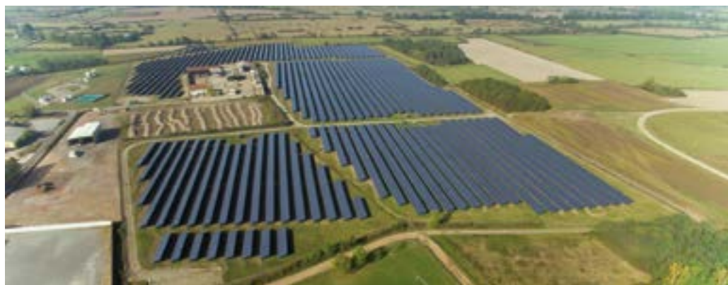
La ferme photovoltaïque
