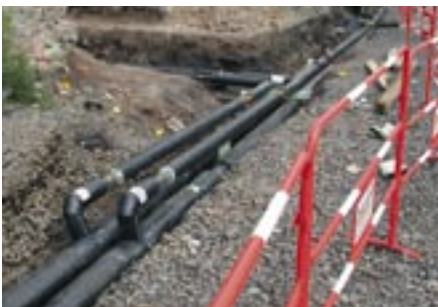
La mise en place du réseau de chaleur
