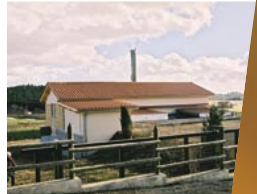
La chaufferie : une construction de petite taille s'insérant bien dans le paysage
