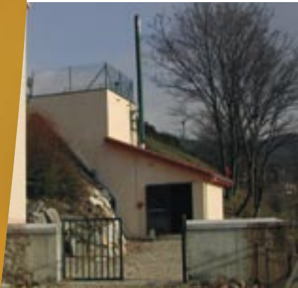
La chaufferie surmontée de son silo à déchets de bois
