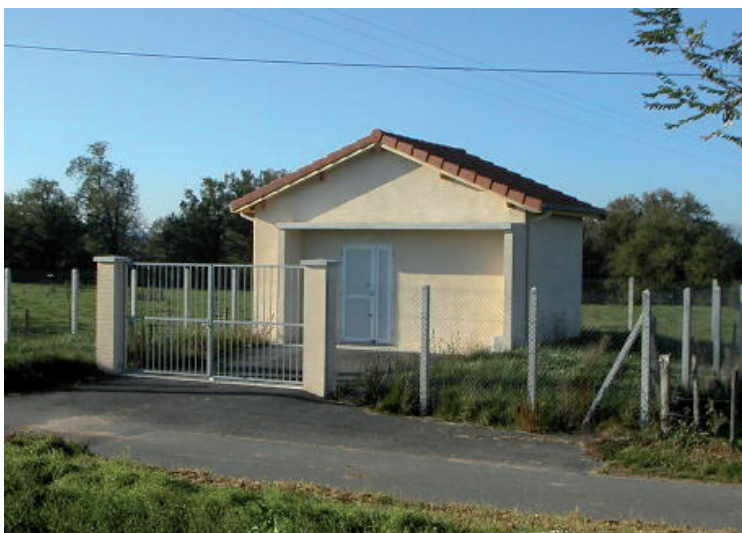
Station de pompage interconnexion SI Lignon - SI Bombarde.
