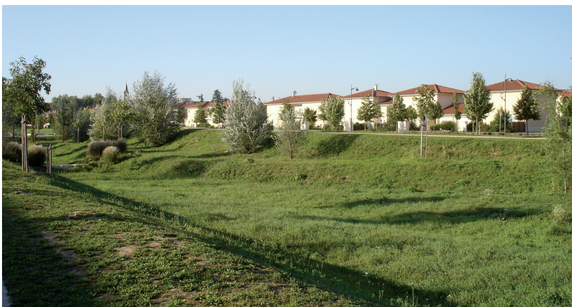
Coulée verte recueillant des eaux pluviales, quartier Borlione, Corbas 69
