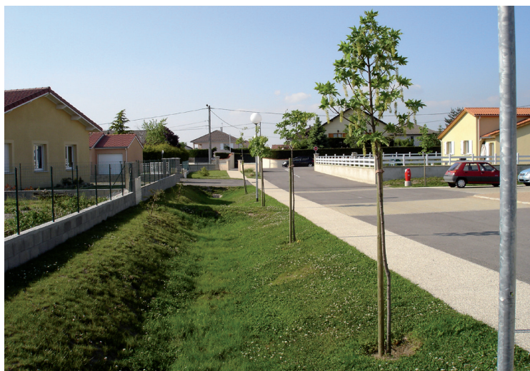
Opération de lotissement à Veauche
