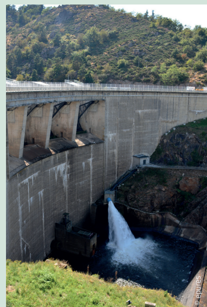
Barrage de Grangent
