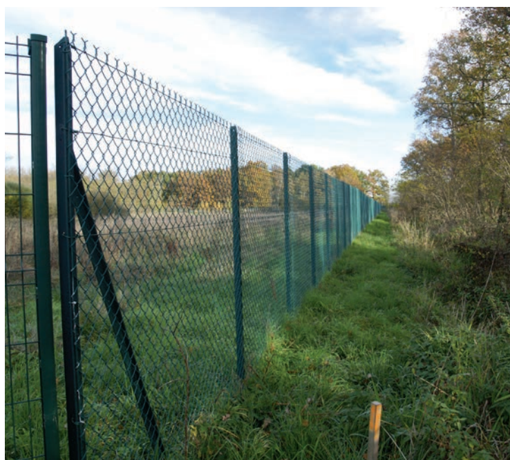
Exemple de clôture étanche au déplacement de la faune
