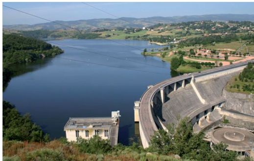
Barrage de Villerest
