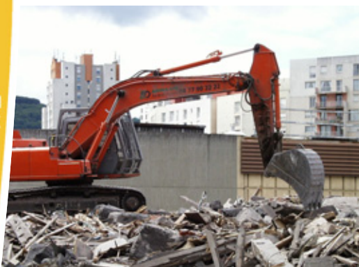
une friche en démolition
