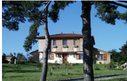
Maison à ossature bois
