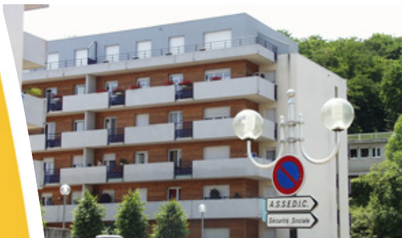
Immeuble récent, quartier Grouchy St-Etienne
